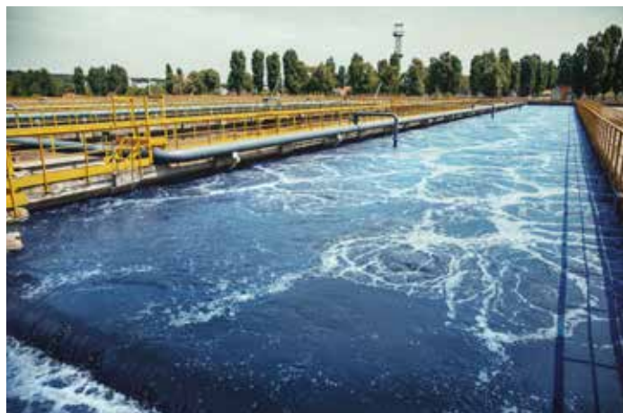
▲ Bekkevoort bouwt een nieuw waterzuiveringsstation.
